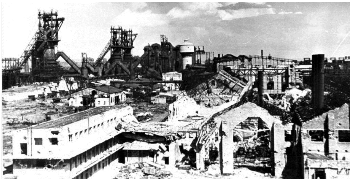
Рис. Разрушенные цеха Керченского металлургического завода им. П.Л. Войкова в г. Керчь.
